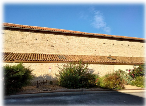
Nettoyage toiture salle des fêtes
